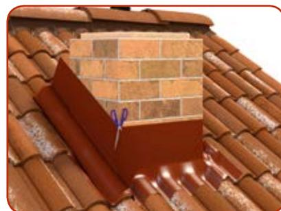
Impermeabilizzare lateralmente sui due fianchi ponendo particolare attenzione alle zone di raccordo.
