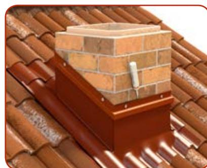
Tagliare e fissare il listello per Wakaflex®. Sigillare con colla butilica resistente ai raggi UV il bordo superiore.
