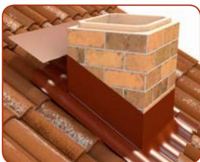
Impermeabilizzare nella parte superiore dell'elemento ricoprendo una fila intera di tegole.
